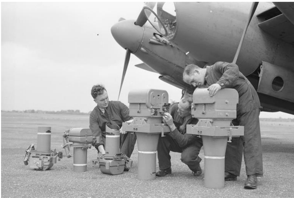
Jordpersonel på RAF Benson foran en Mosquito IX. Fra venstre ses to F.25 (14 tommer linser) kamera til vertikale billeder, en F.24 til skråtfotograferede billeder samt to F.52 (36 tommer linser) 'split pair' til vertikale billeder. (IWM)
