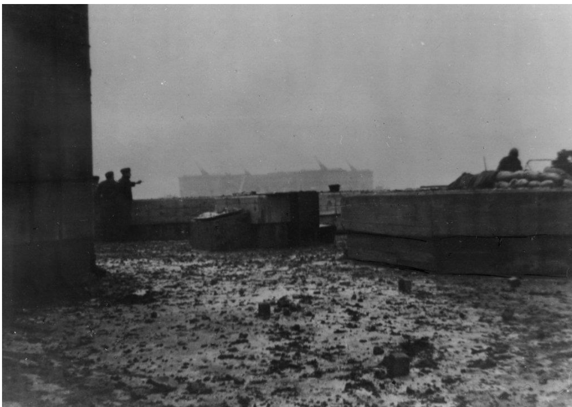
Flakbunker efter et angreb med murbrokker og sprængstykker strøet over afsatsen. Som ekstra sikkerhed mod sprængstykker har soldaterne til højre i billedet forstærket deres kampplads med sandsække.
