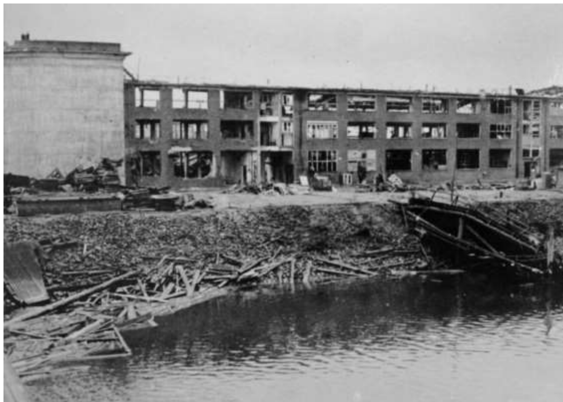
Ødelagt samlehal på Deutsche Werke i Hamburg. Til venstre i billedet ses et værftets beskyttelsesrum.
