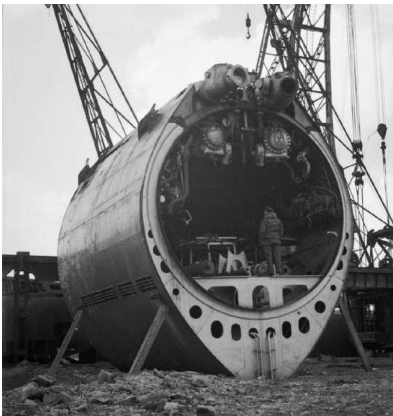
Prefabrikeret ubådselement i Hamburg i maj 1945.
