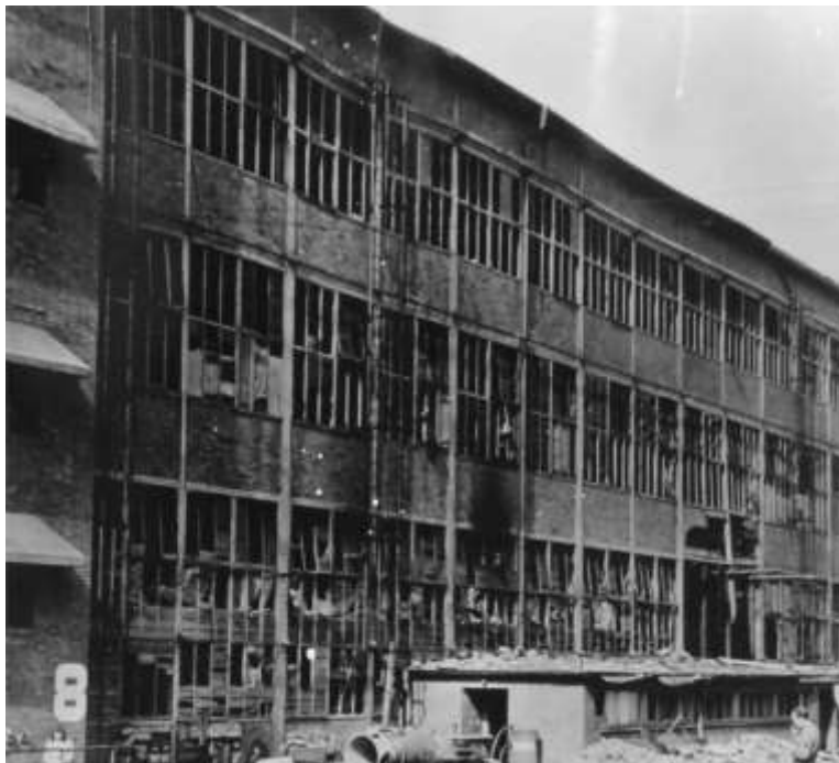
Bygning 29 på Howaldtswerke, der viser tydelige tegn på trykkskader fra detonerende sprængbomber. Til venstre i billedet kan man skimte trappeopgangen, der var ombygget til at kunne fungere som beskyttelsesrum. Markiserne over vinduerne er af armeret beton.
