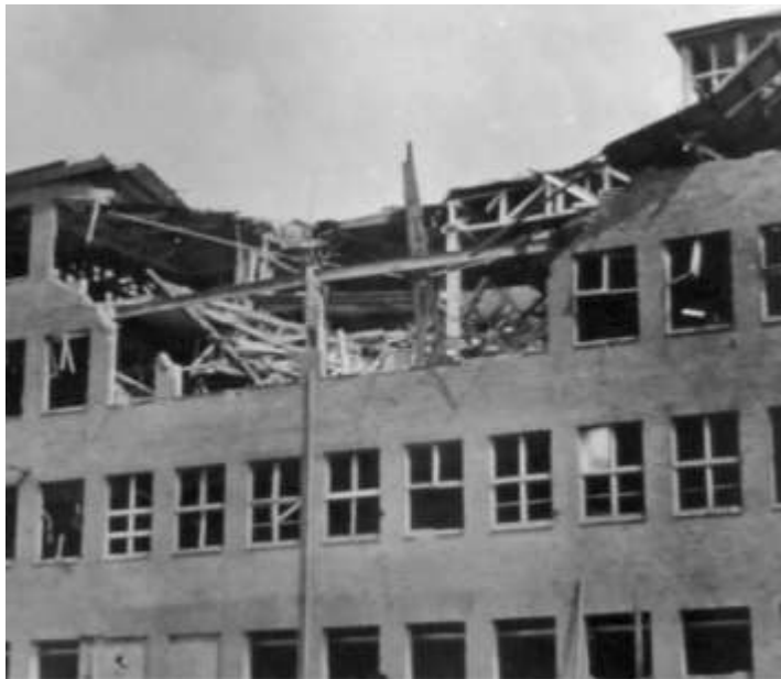
Skader på bygning 105 på Howalds- werke, der blev ramt af en 500 lb sprængbombe.
