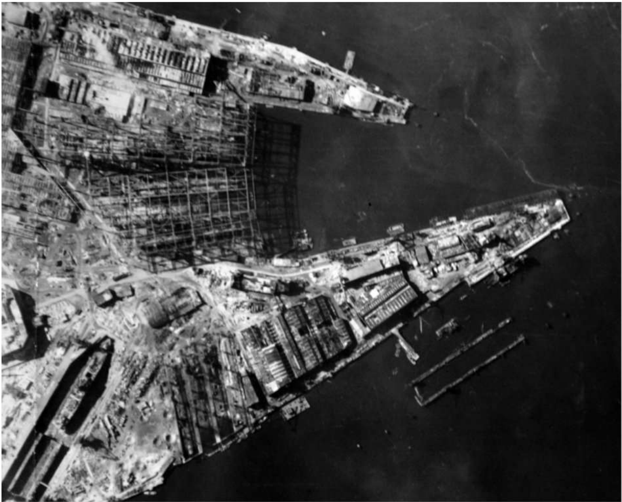
Blohm & Voss skibsværftet i Hamburg fotograferet i 1945. På billedet ses tydeligt en række ubåde under bygning på de delvis overdækkede beddinge midt i billedet.
