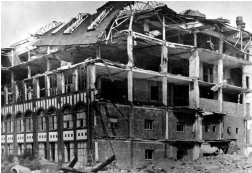
Bygning 75 på Howaldswerke, der blev ramt af to træffere samt en 500 lbs nærvedtræffer.
