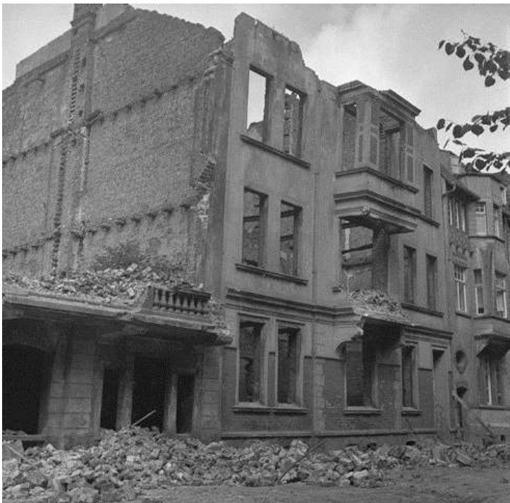
Udbombede bygninger på Kaiserring i Wesel.
