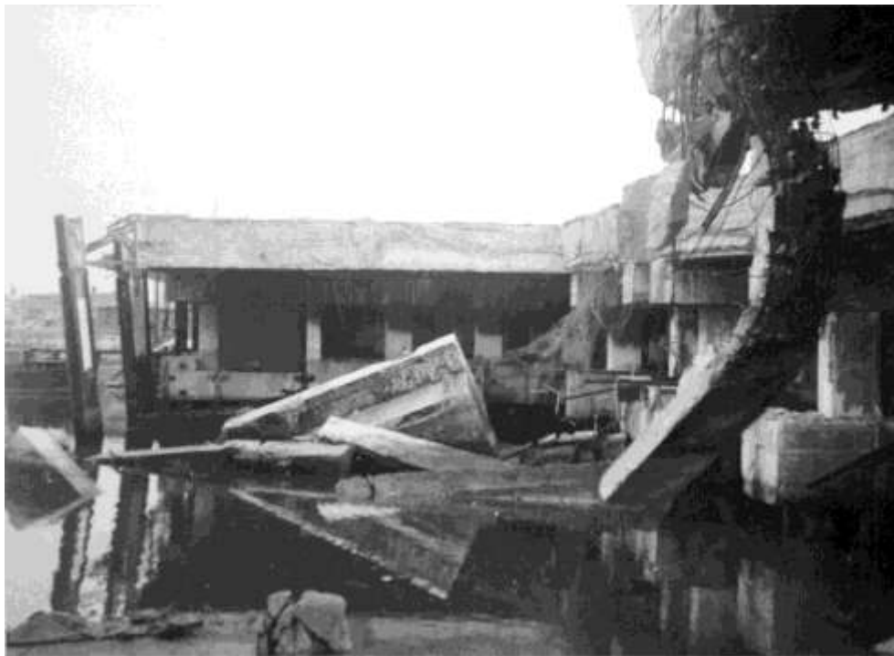
Søsiden af den gamle motortorpedobådsbunker i IJmuiden efter bombeangreb fotograferet fra kaj 9/10.
