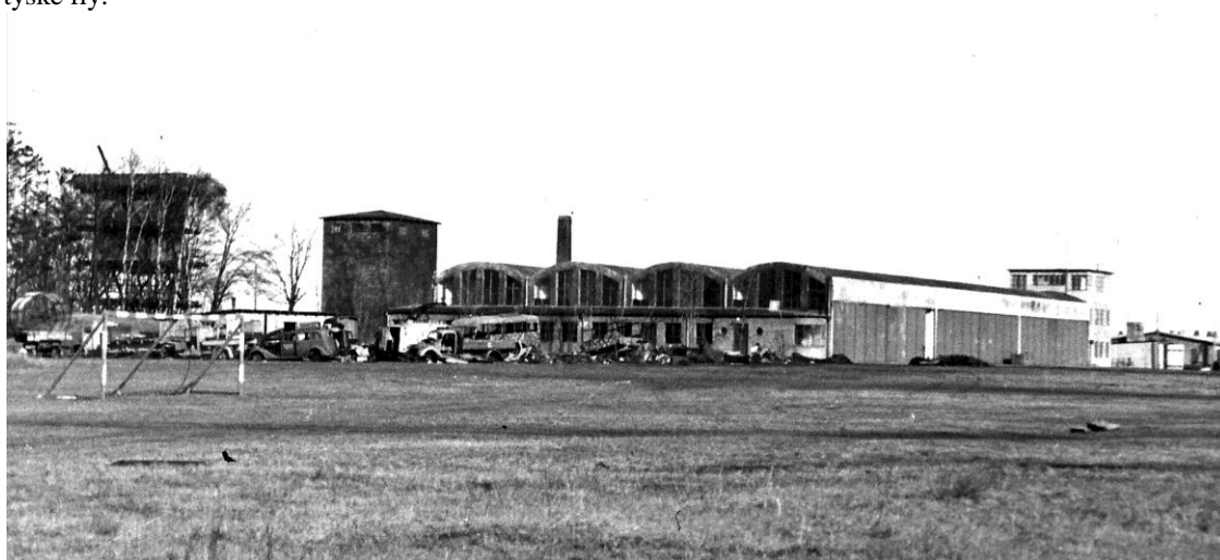
Hangar og flyvekontrol på Værløse. Bemærk det 9 meter høje flaktårn til venstre i billedet. Tårnet var forsynet med en 20 mm luftværnskanon på en 6 x 6 meter platform med skur til underbringelse af mandskabet nedenfor. (RDAF)
