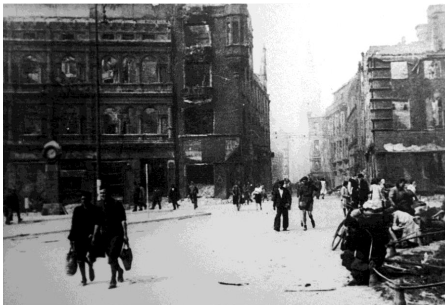
Den indre del af Königsberg efter bombardementet. Münzplatz i retning af Junkerstrasse. I baggrunden ses Altstädische Kirche. Overlevende indbyggerne er på vej gennem byen med deres personlige ejendele.
