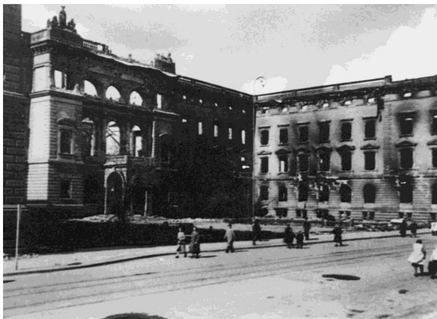
Det udbombede Regierungsgebäude i Königsberg.
