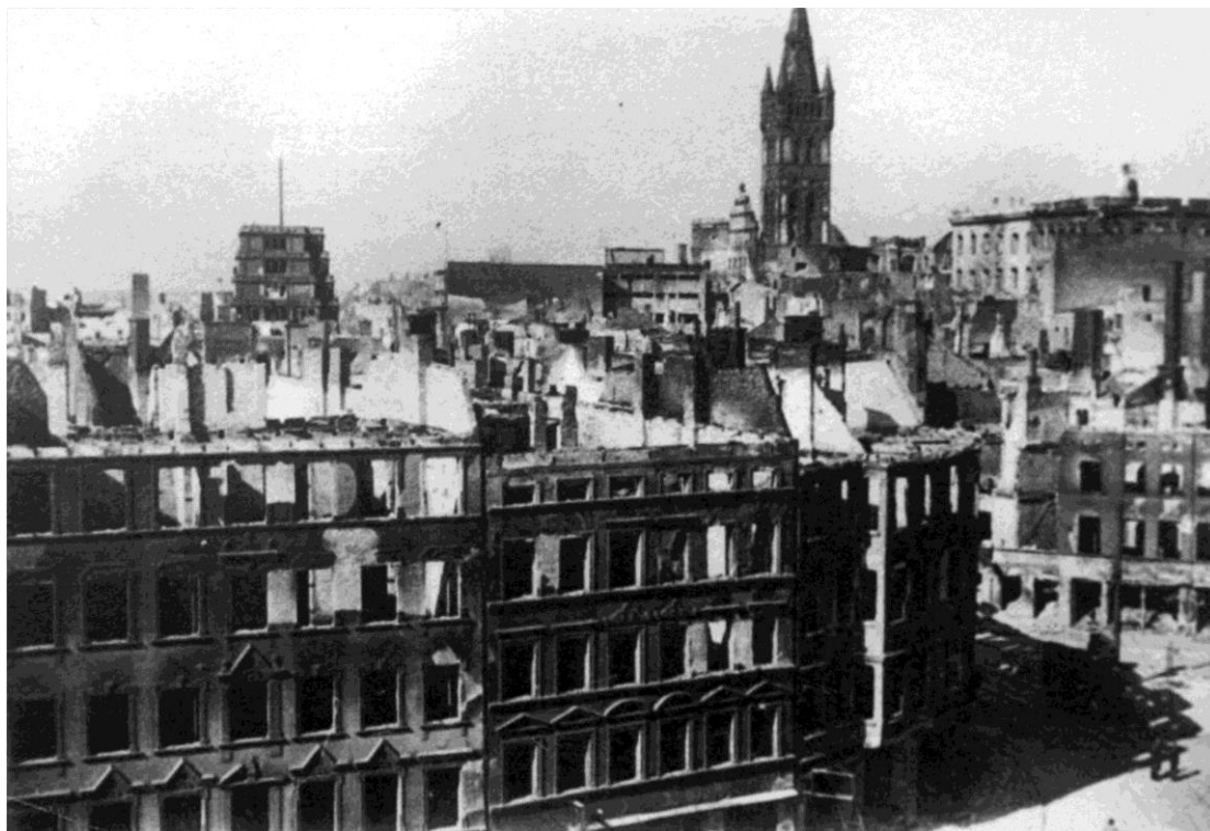
Ødelagte bygninger i Königsberg. På billedet ses tydeligt Kiewe samt slotstårnet. Hele området er totalt udbrændt efter en alt fortærende fladebrand, der bevægede sig med ca en kilometer i timen.
