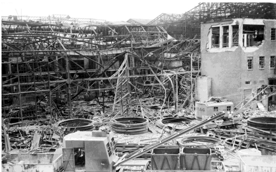
Germania Werft i 1945. Bygning 64 på Germania Werft, hvor man forarbejdede plader og profiljern. (C. Petersen)
