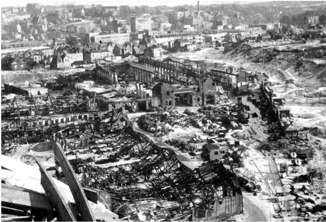
Det totalt udbombede Marine Arsenal ved krigens slutning. (C. Petersen)
