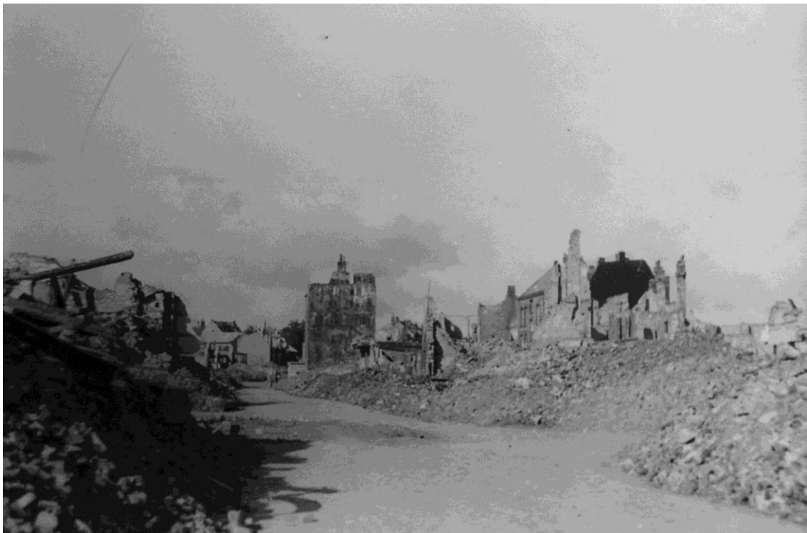
Totalt udbombet område i Kiel i 1944. Gennemgående gader er ryddet, så man kan komme frem, men der er intet brugbart tilbage i området.(C. Petersen)
