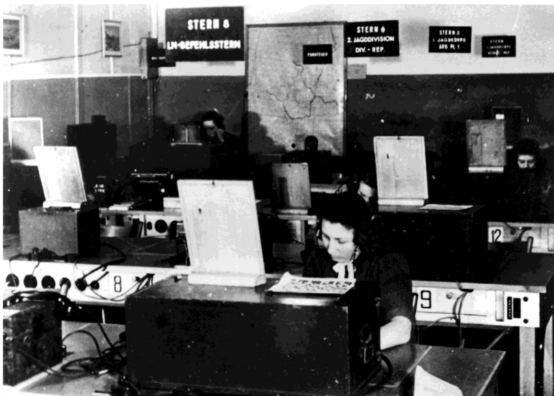
Fjernskrivercentralen i 2. Jagddivisions kommandobunker Sokrates ved Stade. Bemærk skiltene på væggen, der angiver hvilke forbindelser man havde via forskellige kredsløbsgrupper (benævnt Stern på grund af den skematiske opsætning). Ved at kommunikere via en Stern kunne man sende det samme signal til en masse stationer samtidig. Stern 6 var således 2. Jagddivisions divisionsreportage, der blev sendt til et utal af underlagte enheder.
