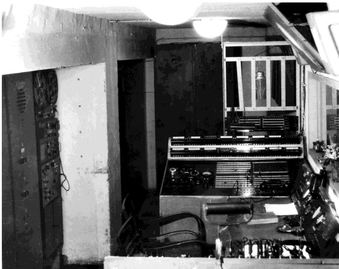
Ingenieur Leitstand med kontrolpult og Reportage Verstärker med båndoptager. Fra denne position kontrollerede den ledende ingeniør alle kommunikationsfaciliteter i operationsrummet.
